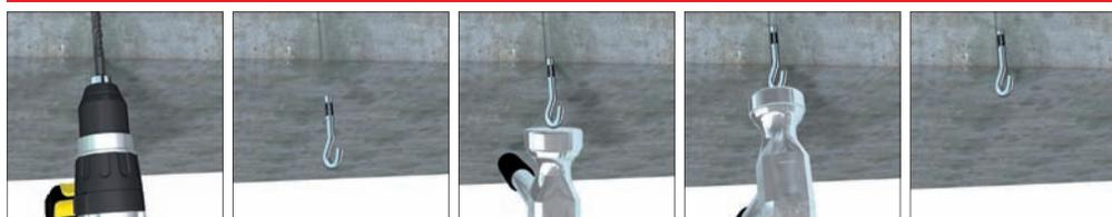
Si raccomanda un'accurata pulizia del foro prima dell'installazione.
