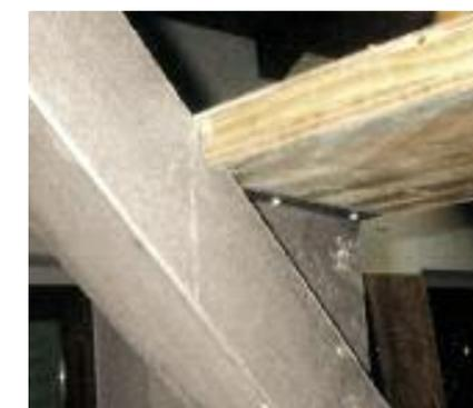
Ogni gradino è sorretto, su ciascun montante, da una staffa triangolare saldata, sulla cui flangia piegata a L e forata si inseriscono due viti dal basso. Per incastrarsi perfettamente nel montante il gradino porta in corrispondenza una scanalatura a 45°.
