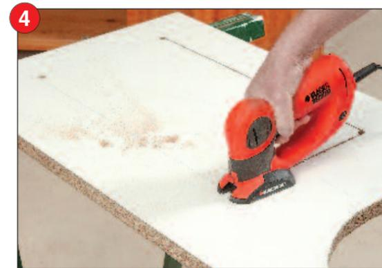
**3: il piano è in truciolare binobilitato**: si trova facilmente nei brico-center, per esempio già rifinito da un lato come mensola, o da rifinire con nastro termoadesivo; con lo stesso materiale realizziamo anche il divisorio e il ripiano superiore. Prima di posizionarlo realizziamo con il seghetto alternativo il taglio circolare per il lavabo.
