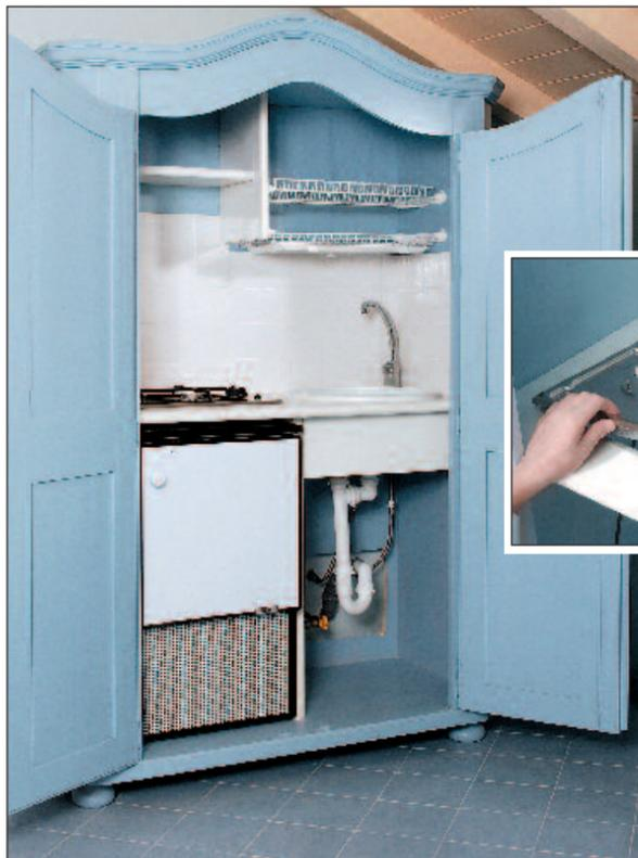
*Il piano cottura è a due fuochi, del tipo per camper, con manopole di comando da un lato e griglia poggiapentole; anch'esso si incastra nel truciolare fissandolo con l'apposita pasta resistente al calore; è collegato a un tubo del gas che va a un rubinetto, per la chiusura di sicurezza. Deve sempre trattarsi di materiale a norma, certificato per gas, mai attacchi improvvisati e tubi non idonei.*
